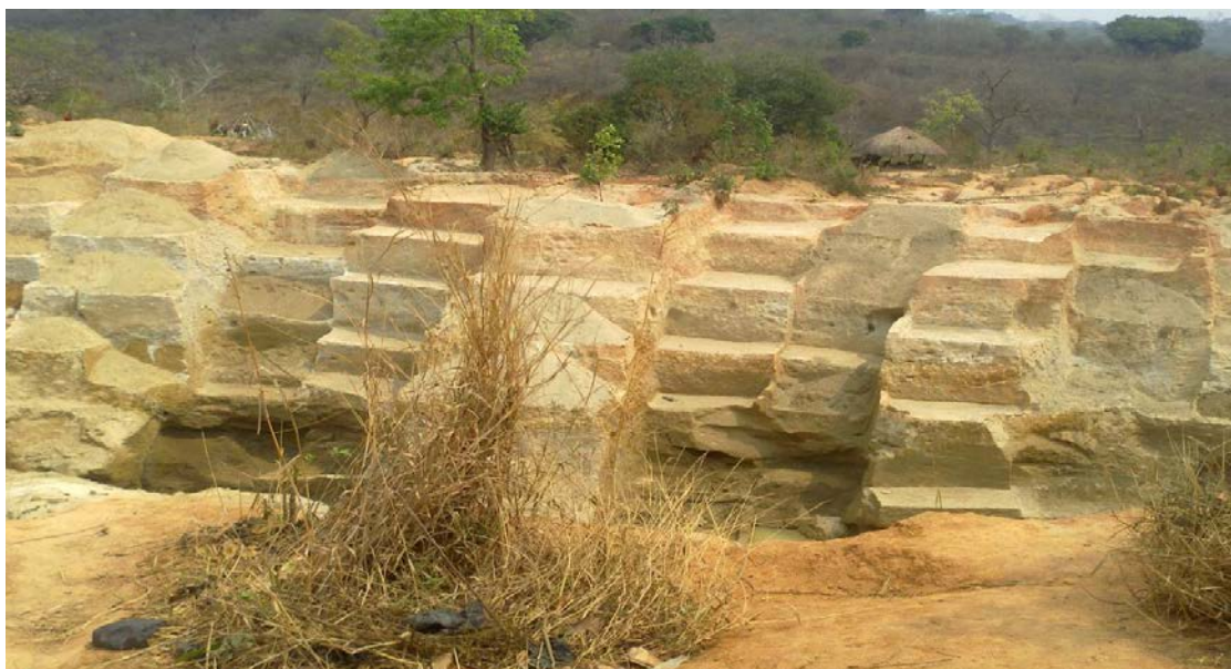
Figura 3: Escavação em escadaria
