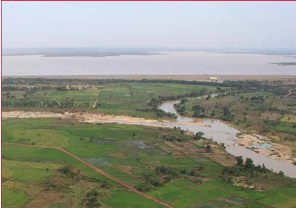
Le barrage de Bagré et son périmètre irrigué, Burkina Faso
