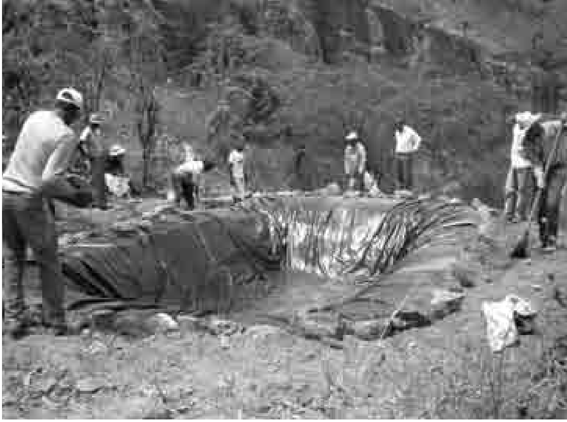
شكل 7: "مينجا" أو حفلة عمل لمساعدة أحد الزملاء على تركيب خزان أرضي مبطن
