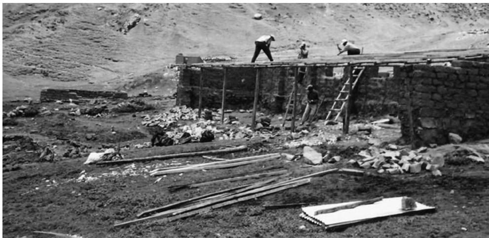
Construcción de cobertizo para alpacas: el refugio permite que sobrevivan a condiciones climáticas extremas. Fuente: Soluciones Prácticas
